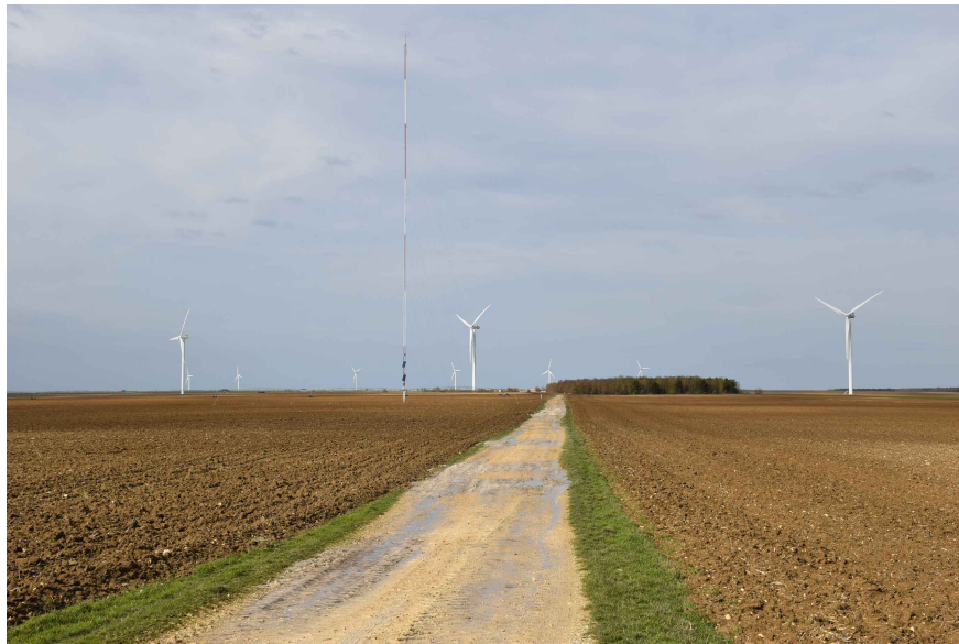
VUE 3 : Photographie environnement proche
