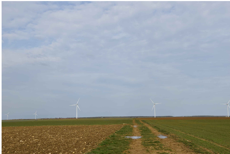
VUE 1 : Photographie environnement proche
